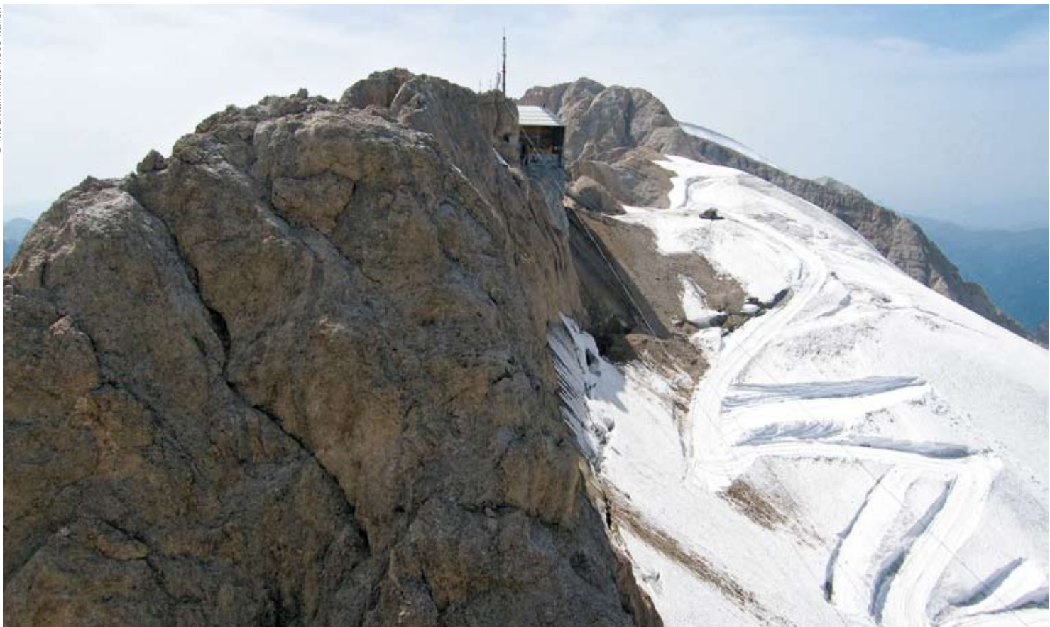
Postaja gorske žičnice na Marmoladi in cesta, ki je speljana po ledeniku in zgrajena le zaradi vzdrževanja žičnice.
